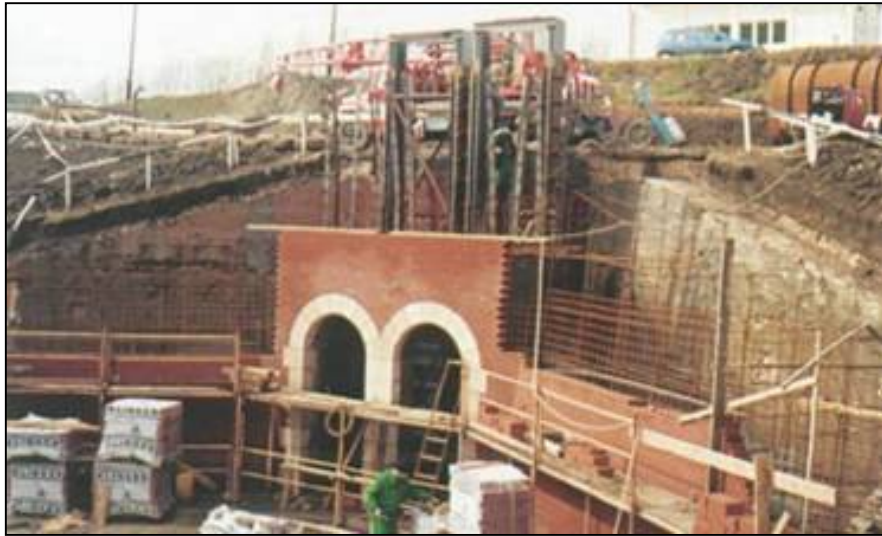
3. kép. A Kurca torkolati zsilipje a 2000–2001. évi korszerűsítéskor (homlokzat és ferde szárnyfalak építése) [Sulinet]
